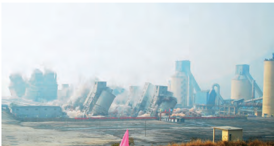
原山东安厦水泥集团有限公司9条机立窑生产线集中爆破现场
