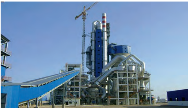
集团承建国际工程项目——也门日产3000吨水泥生产线原料磨及废气处理系统
