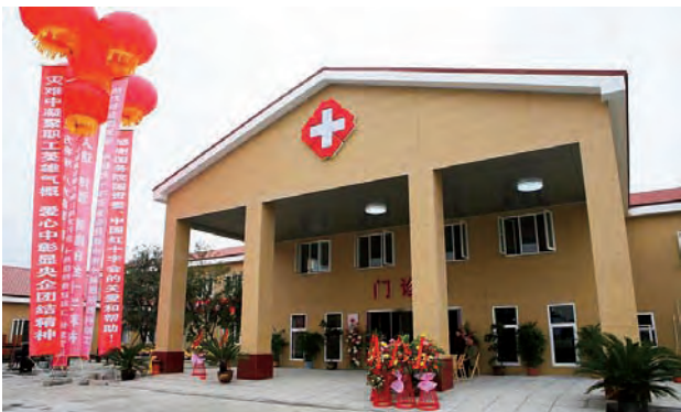
集团援建项目——中国水利水电第十工程局医院
