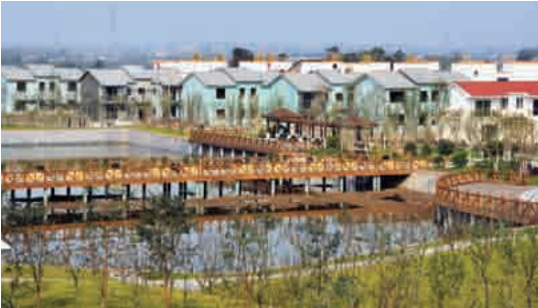
北新集团成都青白江区清泉镇花园村项目
