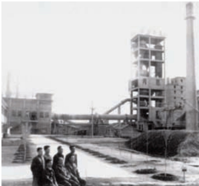
开发成功水泥煅烧预分解技术，为我国水泥工业实现以新型干法生产为主体的产业结构调整奠定了基础
